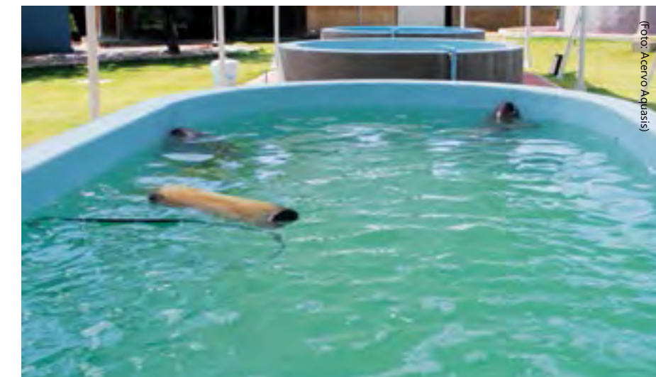
Figura 10. Tanque de reabilitação de concreto revestido com pintura epóxi.
